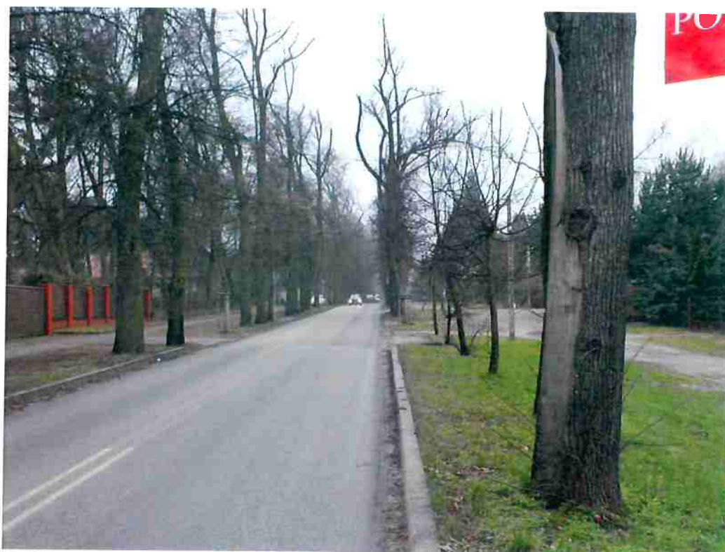
Fot. 1. Liczne drzewa noszą ślady uszkodzeń spowodowanych kolizją z pojazdami
